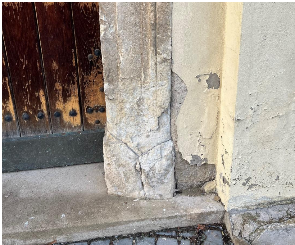
Zcela poškozená, prasklá pravá pata portálu, kámen je degradovaný, zvětralý.
