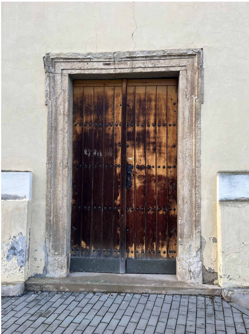
Boční portál - paty portálu jsou zcela degradované, pravá pata portálu je prasklá, profilace kamene je značně mechanicky poškozená, poškození je také způsobeno vlivem degradace samotného materiálu – opuky.
