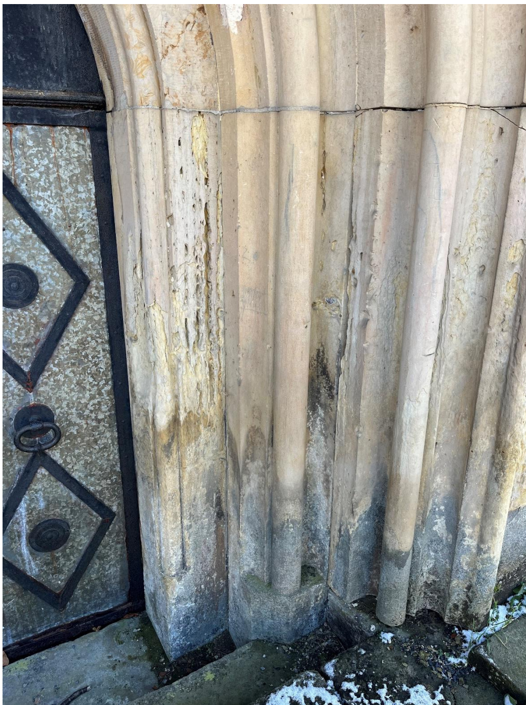
Ve spodní části portálu je kámen poškozený vlivem vztlínající vlhkosti a zasolení kamene.
