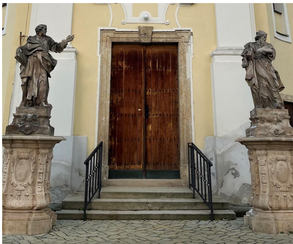
Hlavní portál – portál je mechanicky poškozený, otlučený, dochází k povrchové degradaci kamene
