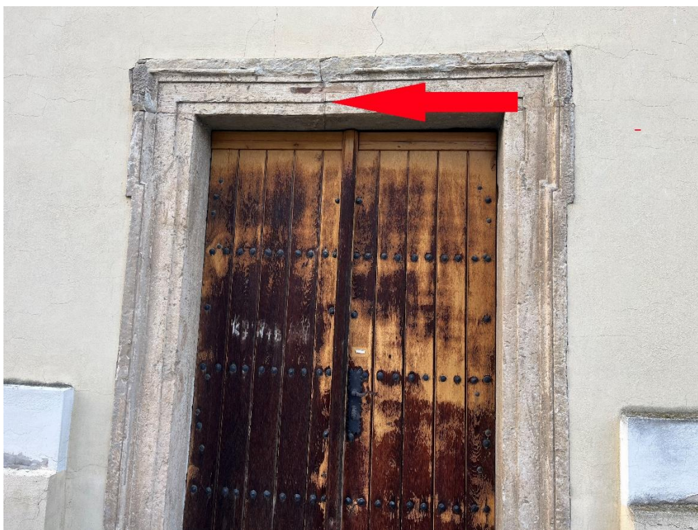
Prasklina na horním překladu portálu, zajištěna železnou kramlí.
