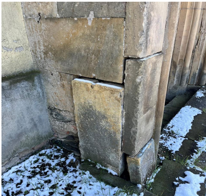
V levé části portálu jsou pískovcové desky uvolněné, vlivem korodovaných kotvících skob.
