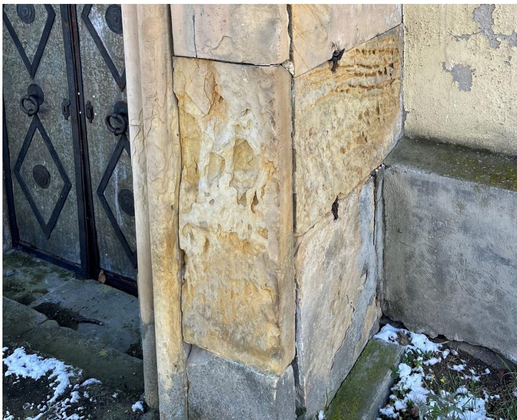
Zcela degradované pískovcové desky v pravé části portálu.
